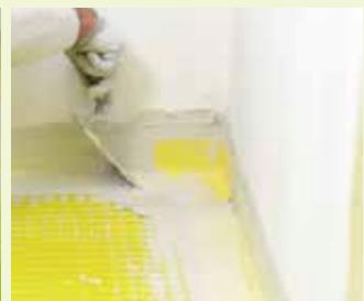
4. Incollare la bandella impermeabilizzante Foiltec sopra le giunzioni tra un foglio e l'altro di Flootec. Incollare gli angoli.
