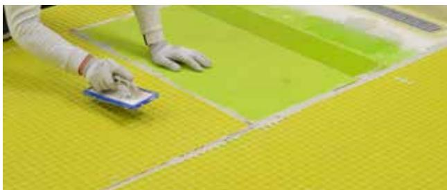
3. Premere per un corretto fissaggio della membrana.
