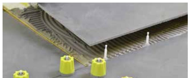
6. Posare il pavimento. Il formato delle piastrelle, esclusivamente posate con la tecnica "a letto pieno", deve essere almeno 5x5 cm. Con un sottofondo di tipo cementizio è consigliabile un collante di tipo C2.
