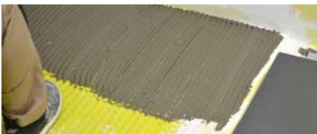
5. Assicurarsi di rasare il collante e colmare completamente le cavità cilindriche della membrana con una spatola liscia e successivamente con una spatola dentata idonea.
